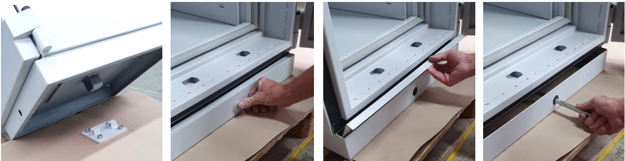
5. Tresor über Verankerungsplatte heben und positionieren
