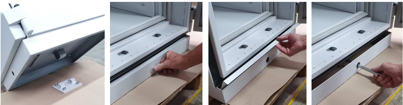
5. Tresor über Verankerungsplatte heben und positionieren
