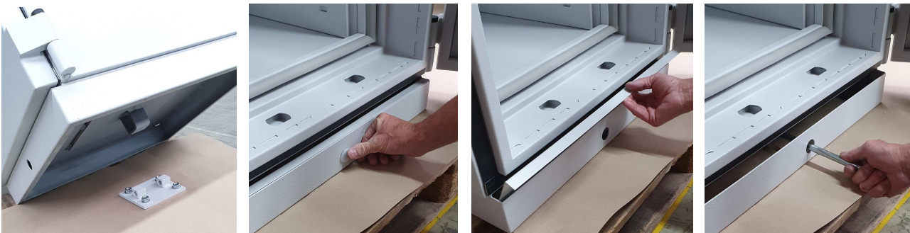
5. Til en plaats de kluis over de verankeringsplaat
